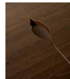
Ouverture sur la tablette de pose bloc prises.
